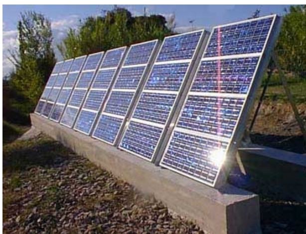
Figure IV-1 : 32 modules solaires montés pour l'alimentation.
