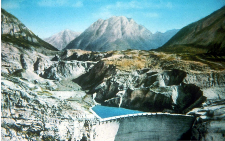
Le barrage du Vajont lors de la mise en eau du pied du talus du mont Toc qui a été submergé, ce qui activa le glissement
