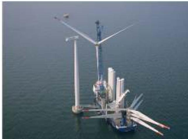
**Fig. 1.15 Montage des éoliennes de 2.3 MW**
