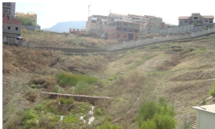
Glissement de terrain dans les argiles de Bastos (Tizi Ouzou)
