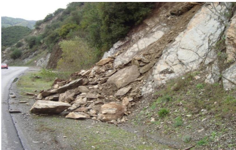
Ecroulement de blocs rocheux sous l'effet de la pente
