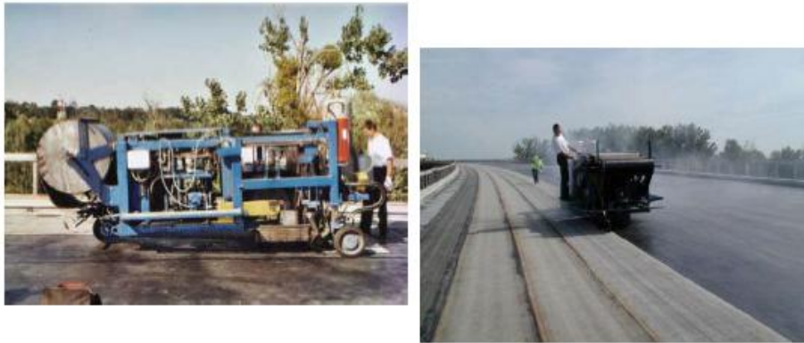
Figure.7 : Étanchéité du tablier
