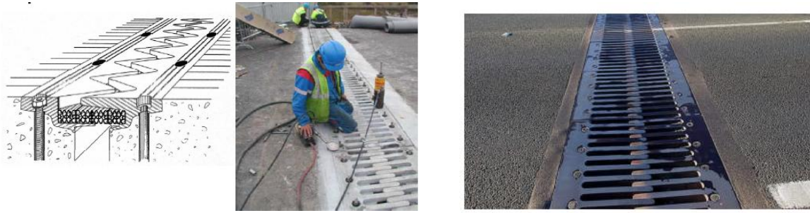
Figure.11: Réalisation de joints de chaussée des ponts
