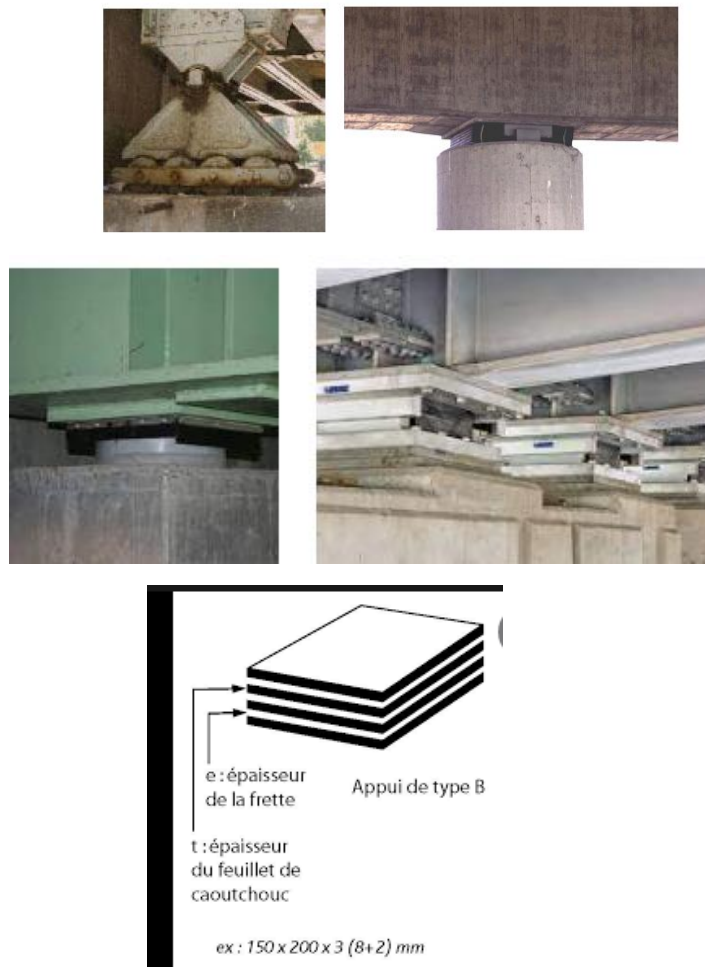
Figure.23 : Types et constitution des appareils appui.
