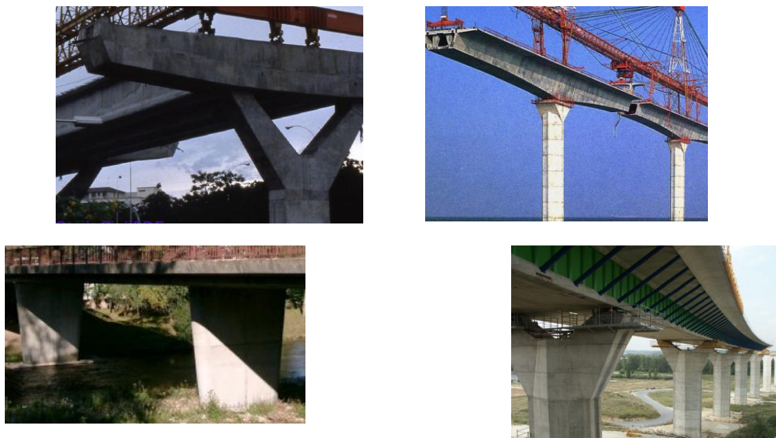
Figure. 17 : Formes particulières des piles.
