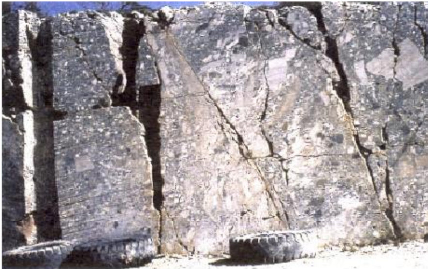
Figure 1 – Front de taille découpé au fil : le massif rocheux, milieu hétérogène, discontinu et anisotrope.
