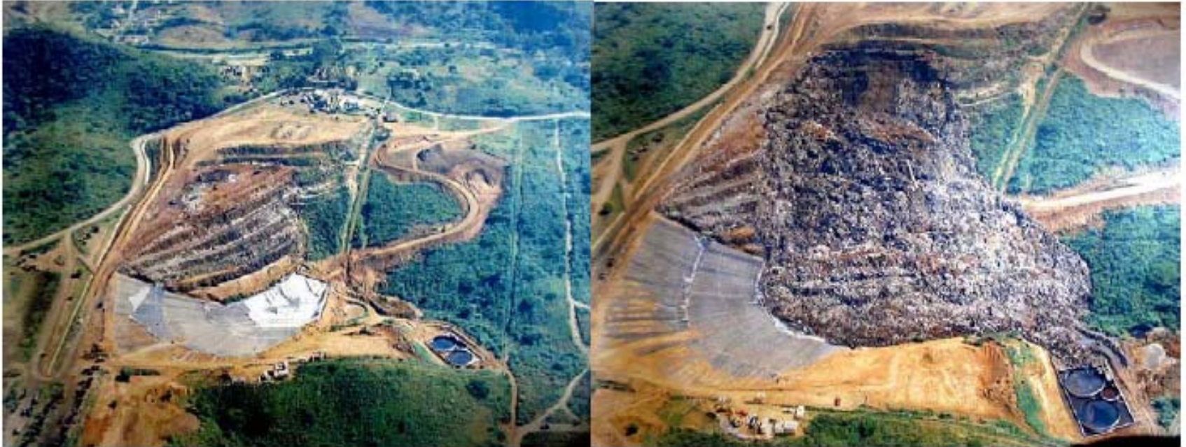
Figure 10.1 Photo aérienne du talus de Bulbul Drive (Afrique du Sud) avant et après rupture (Brink et al., 1999)
