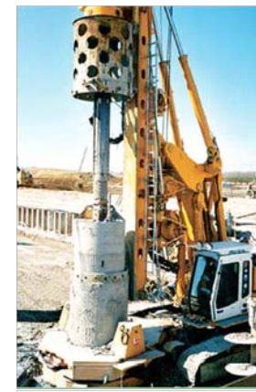
Les pieux de fondation pour chauffer les bâtiments
