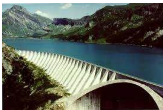
Figure 5.9: Barrage EDF de Roseland dans le Beaufortain – source : photo EDF
