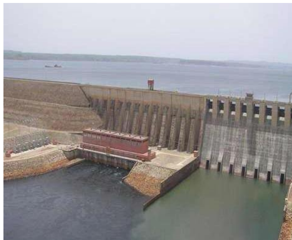
Figure 5.13: Centrale hydroélectrique de Manantali au Mali, 200 MW, 5 groupes Kaplan sous 46 m de chute
