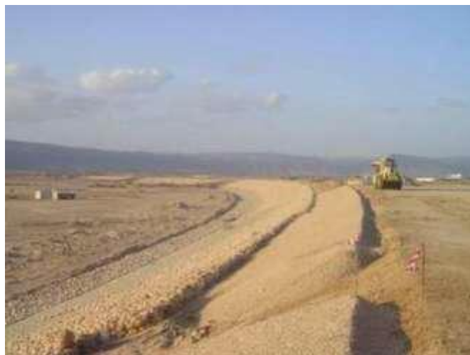
Figure 5.6: Construction du barrage de Salalah à Oman, barrage en terre avec paroi en béton plastique, hauteur 22m, longueur 6 km
