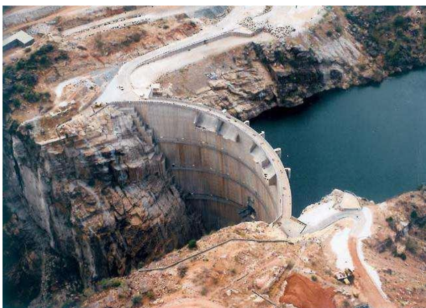
Figure 5.7: Barrage voute de Turkwel au Kenya, hauteur 155 m, longueur en crête 170 m
