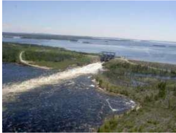
Figure 5.12: Centrale hydroélectrique de La Sarcelle, complexe de la Baie-James: débit turbiné 1 290 m 3 /s, chute. Nominale 10,8 m, 3 groupes bulbes de 43 MW chacun.
