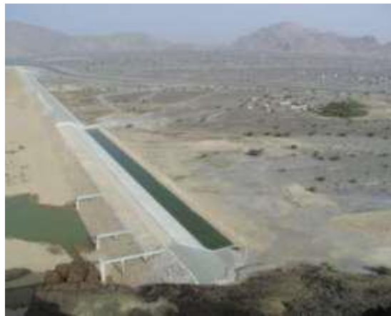
Figure 5.2: Barrage de Muyadin à Oman pour l'amortissement des crues
