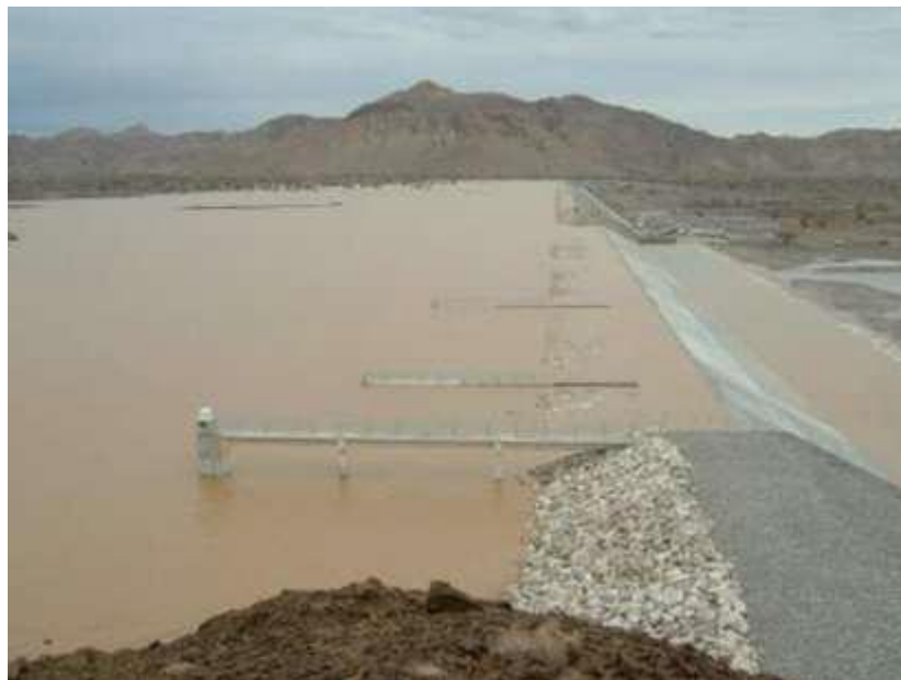
Figure 5.3: bloc évacuateur en béton et digues en remblais
