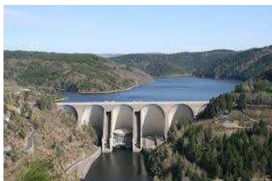
Figure 5.8: Barrage à voutes multiples de Grandval dans le Cantal – source : photo EDF
