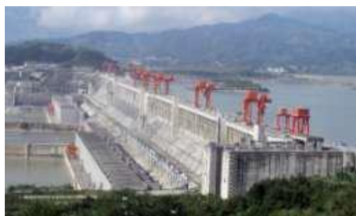
Figure 5.11: Centrale hydroélectrique des Trois Gorges en Chine
