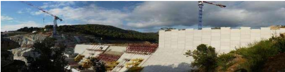
Figure 5.5: Barrage EDF de Rizzanese en Corse, hauteur 40 m, type BCR
