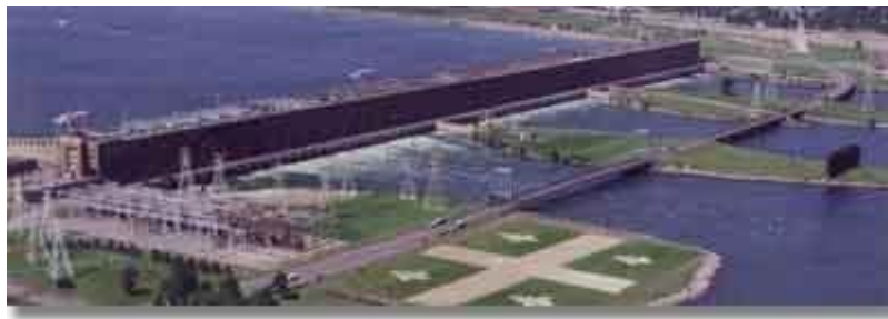
Figure 5.15: Centrale de Beauharnois au Québec : Puissance 1660MW ; hauteur de chute 24m
