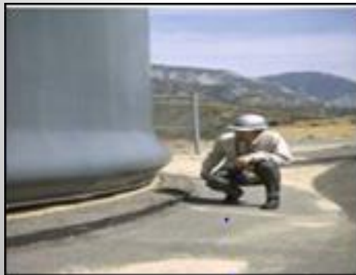
Figure 1-a : flambement en patte d'éléphant
