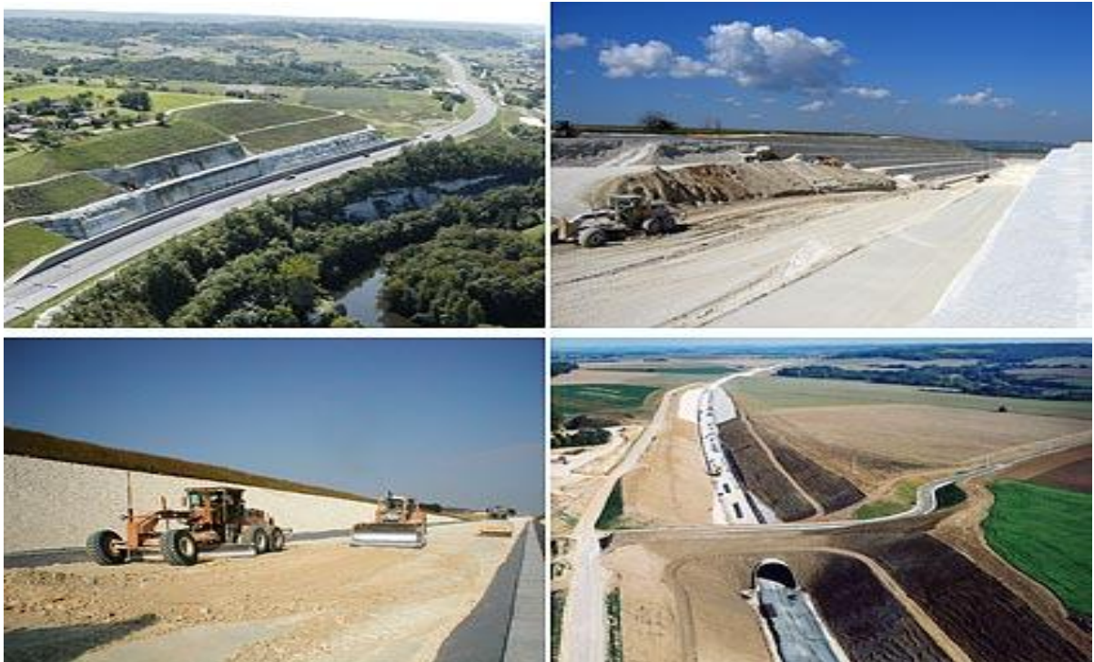
Chantiers de terrassement
