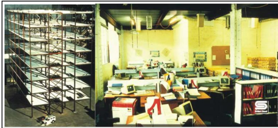
Figure I.1 Bâtiment de Cardington (gauche) et le bureau de l'essai de bureau reconstitué (droite)
