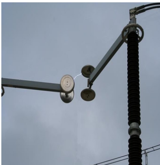
Figure III- 2: Éclateur à air
