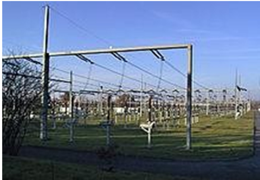
Figure III-15 : Jeu de barres d'un poste 220 kV. À l'arrière-plan un autre jeu de barres est visible.
