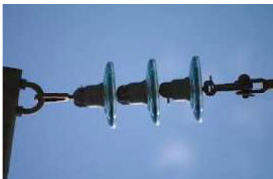
Figure II.3 – Un isolateur.
