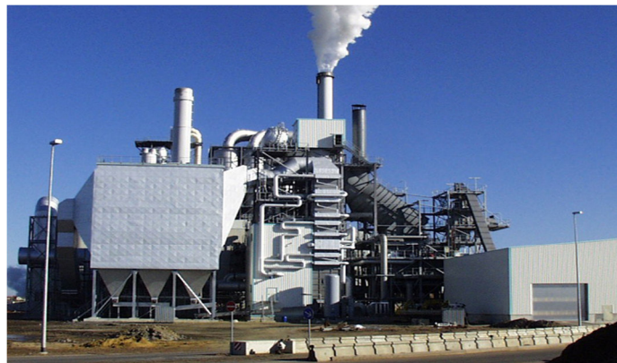
Figure II.13 – Centrale thermique à biomasse.
