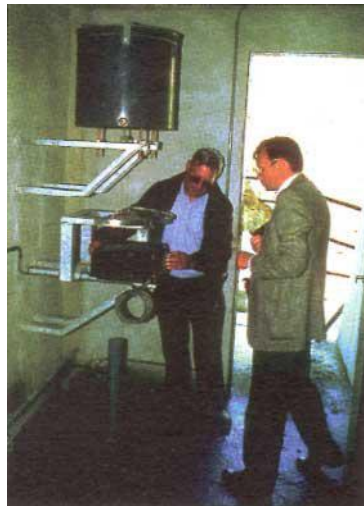
Figure 34 – Auscultation interne d'un barrage par pendule inversé
