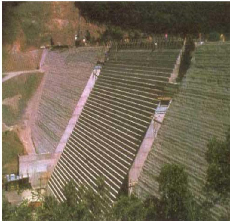
**Fig. 11- barrage poids en BCR en France (Hauteur = 35m)**
