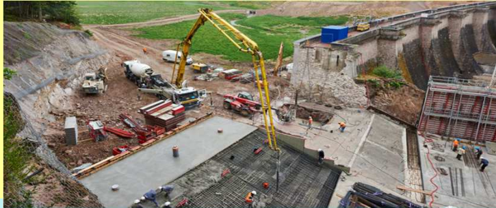
Photo chantier juillet 2015 (VNF)
