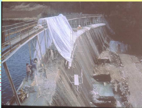
Barrage de la Bourne (1/2)
