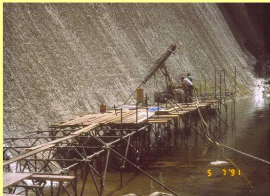
St Martin de Londres (34) Forage de drains inclinés depuis le pied aval
