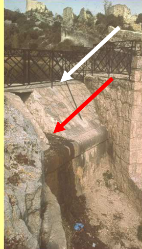
Barrage de St Saturnin d'Apt
