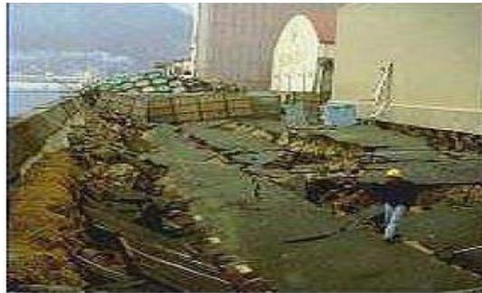
Figure 3.3 Inclinaison des murs de soutènement
