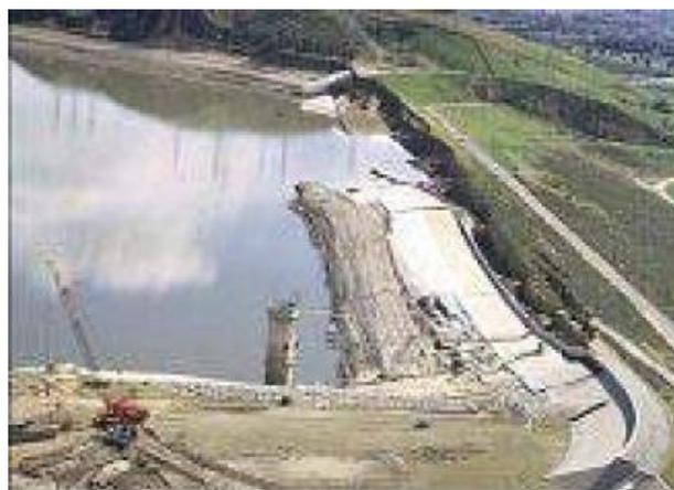
Figure 3.4 Effondrements du parement amont du barrage
