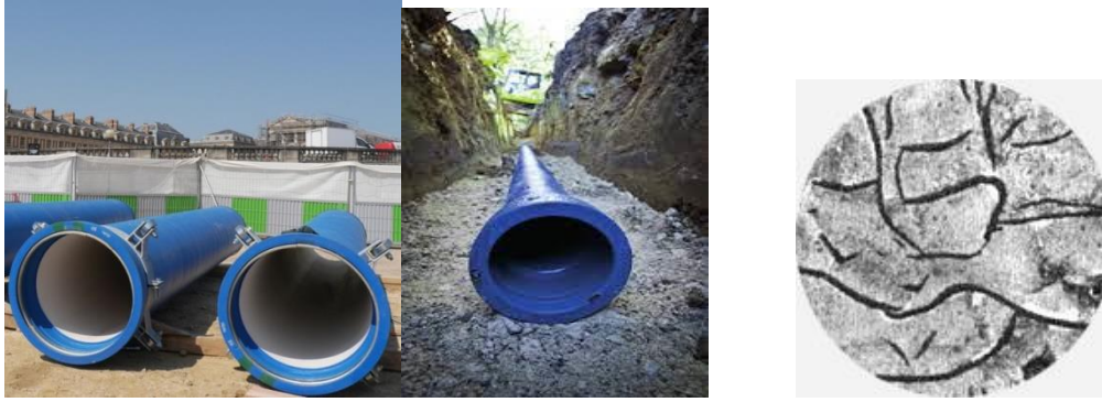
Figure 2 : Conduites en fonte grise.
