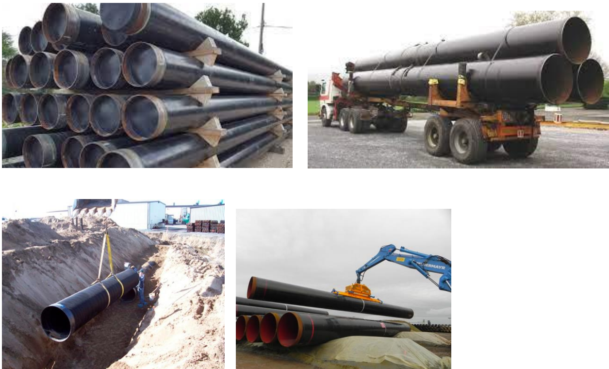
Figure 1 : Conduites en acier.
