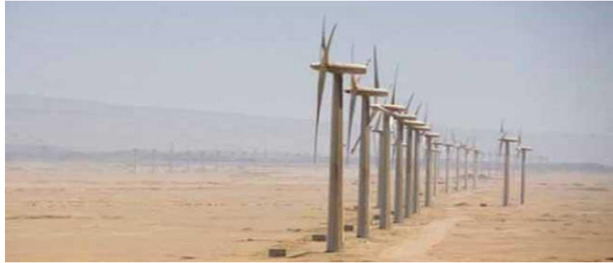
Fig 23 : La première ferme éolienne en Algérie « Adrar »
