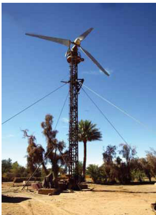
Fig 22 : éolienne de pompage d'Adrar
