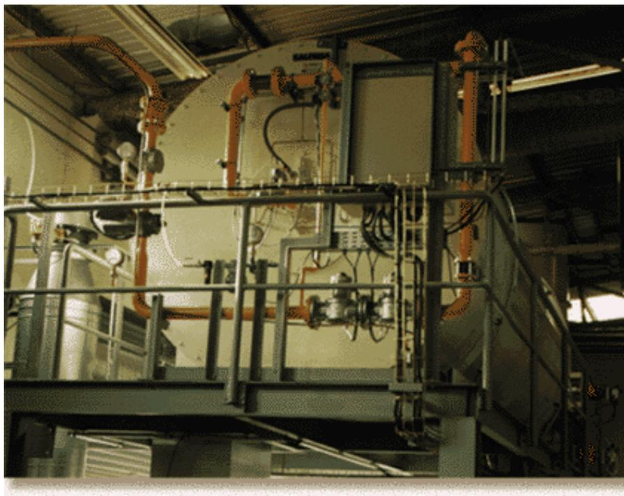
**Figure III.5. Installation d'épuration thermique d'air contaminé avec des solvants**
