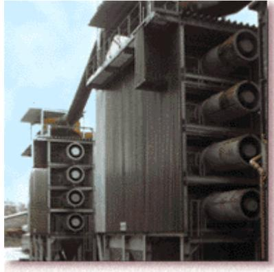
**Figure V.14. Ensemble de deux refroidisseurs de fumées connectés en série, chacun muni de quatre groupes de refroidissement.**
