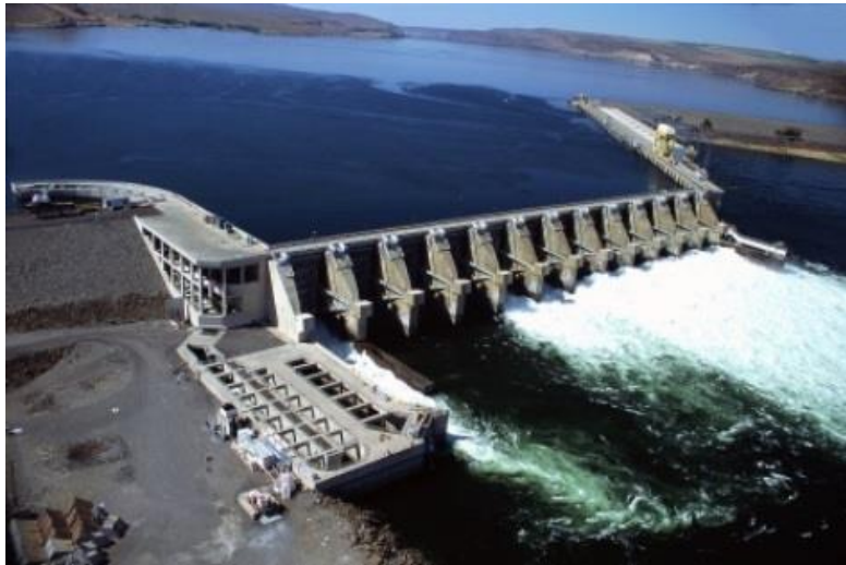
Exemple de barrage avec production d'énergie électrique.
