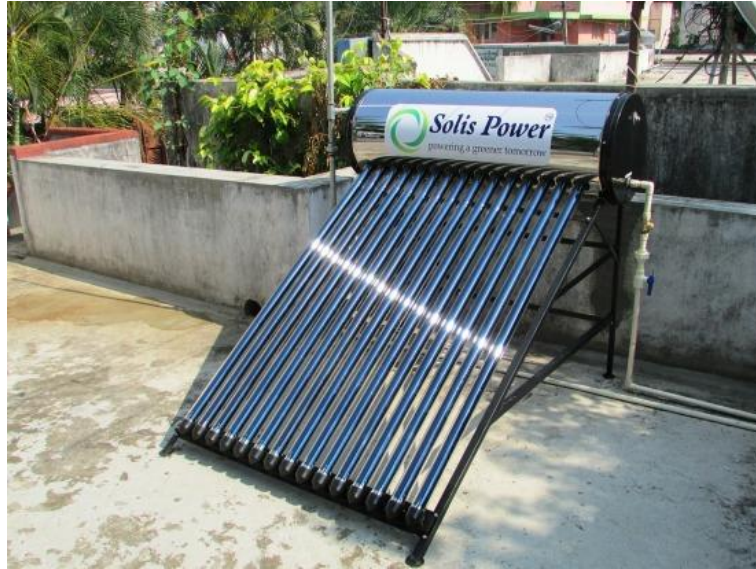
Capteur solaire sous vide.
