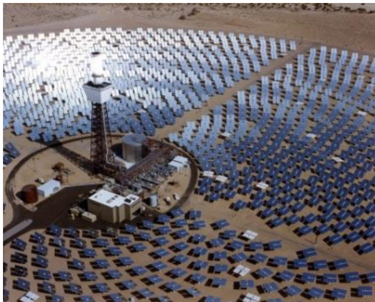
La photo ci-dessous donne un aperçu de quelques héliostats vus de près.
