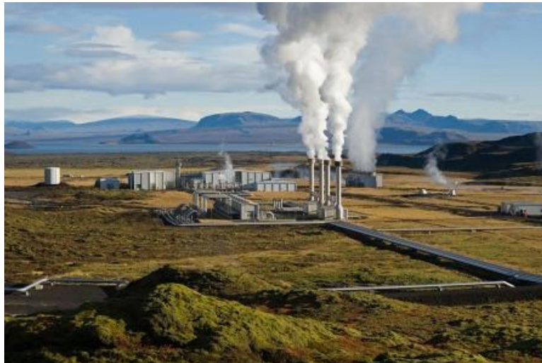
Centrale électrique géothermique.
