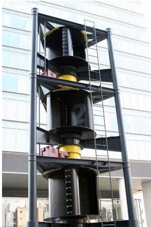
Eolienne Savonius.
