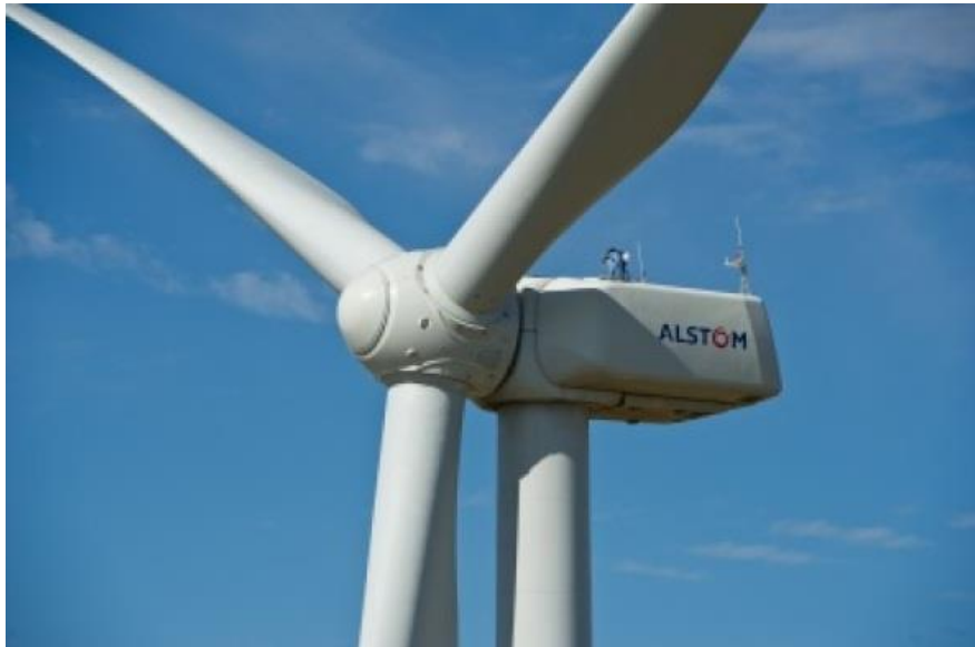
Techniciens travaillant sur une nacelle d'éolienne de 3 MW.
