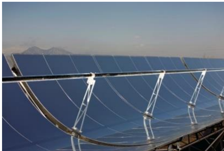
Concentrateur cylindro-parabolique.
