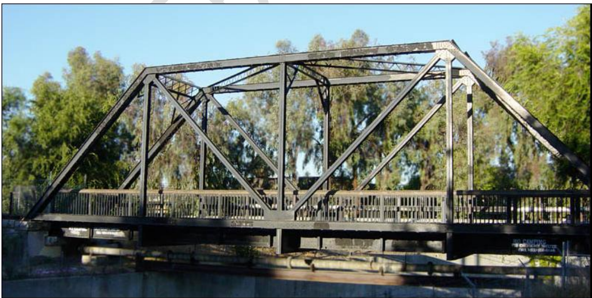
Figure 2.8. Pont en treillis
