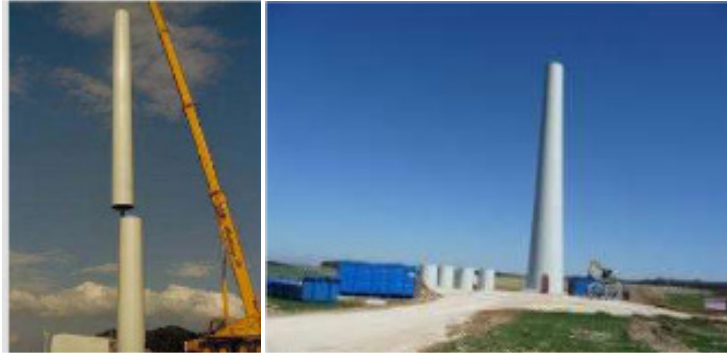
Figure 27. Mât (a) en acier (b) en béton
